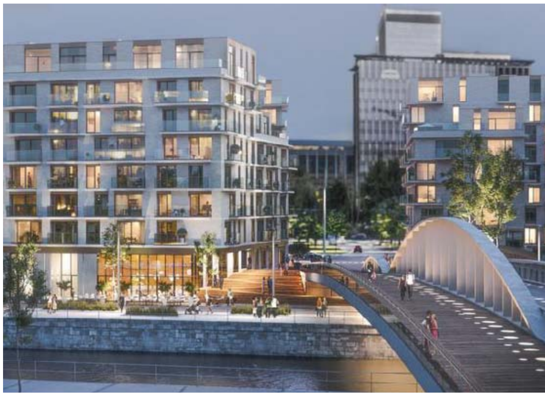
Riva réussit l'intégration de la future passerelle Picard au projet. Le lien avec la ville est ainsi créé. © D.R.
